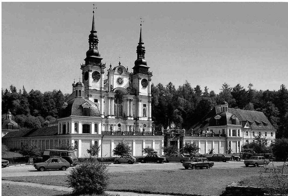
Kościół z krążgankami w Świętej Lipce, zbudował Jerzy Ertly z Wilna w latach 1687-1693.
