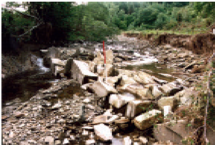
Fot. 4. Świeżo rozcięte koryto skalne Wilszni po powodzi w 2003 roku (odc.10) (fot. 3. i 4. K. Krzemień)
