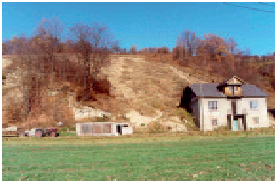
Fot. 3. Dom zniszczony przez osuwisko powstałe na zboczu doliny Łososiny w Kamionce Małej (fot.: 3, 4, 5 E. Gorczyca)
