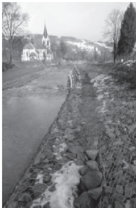
Fot. 3. Zabezpieczenia brzegow potokow (Laskowa - z lewej, Jachowka - z prawej) (fot. M. Angiel)
