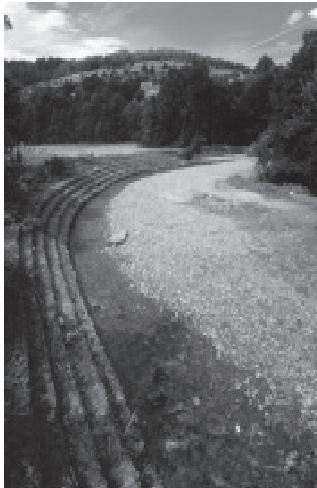
Fot. 3. Zabezpieczenia brzegow potokow (Laskowa - z lewej, Jachowka - z prawej) (fot. M. Angiel)
