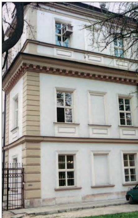
Fot. 1. Collegium Śniadeckiego – widok od strony północnej (fot. J. Mrzygłód) Photo 1. Śniadecki Collegium, view from the North (phot. J. Mrzygłód)
