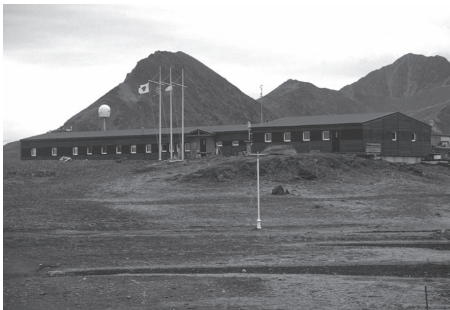
Fot. 4. Hornsund – zabudowania Polskiej Stacji Polarnej
