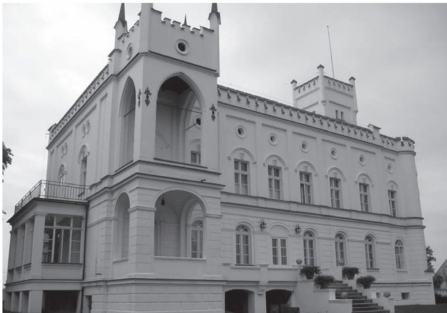
Fot. 3. Widok pałacu w Prężycach
