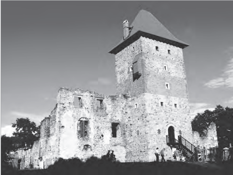
Fot. 2. Ruiny zamku w Chudowie; stan z roku 2010 (fot. www.zamekchudow.pl [dostęp: 10.01.2013])
