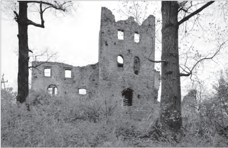
Fot. 1. Ruiny zamku w Chudowie; stan z roku 1995 (fot. www.zamekchudow.pl [dostęp: 10.01.2013])
