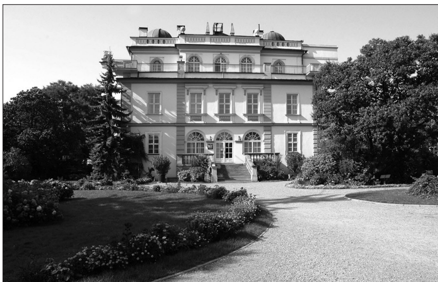
Fot. 1. Collegium Śniadeckiego
