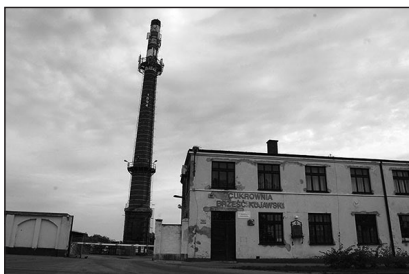
Fot. 3. Budynek po dawnej administracji cukrowni (Fot. M. Balcerak)
