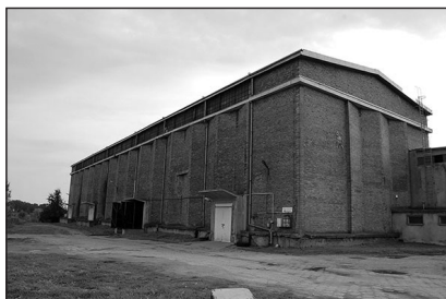
Fot. 4. Budynek po dawnym magazynie (Fot. M. Balcerak)
