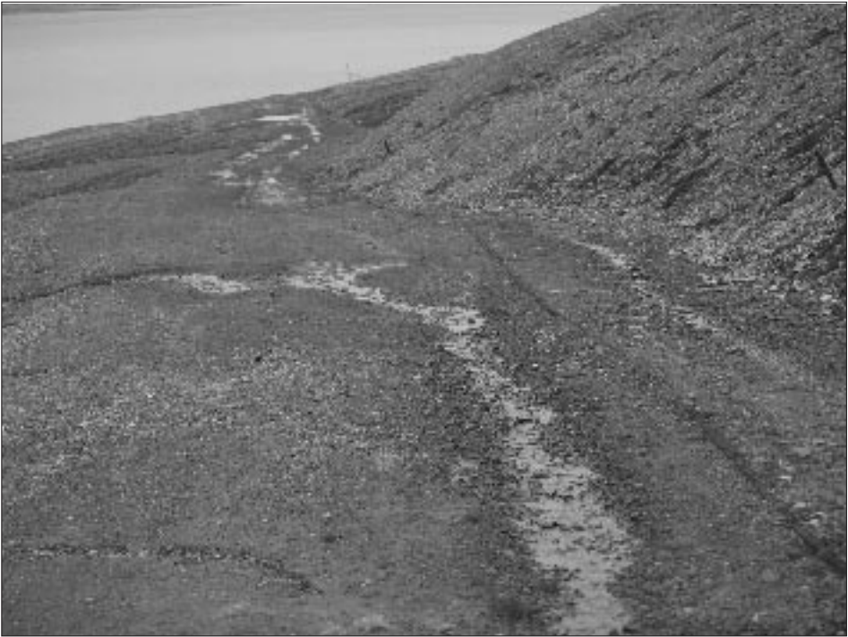
Fot. 1. Drogi bardzo często przejmują funkcję odprowadzania wody ze stoku
