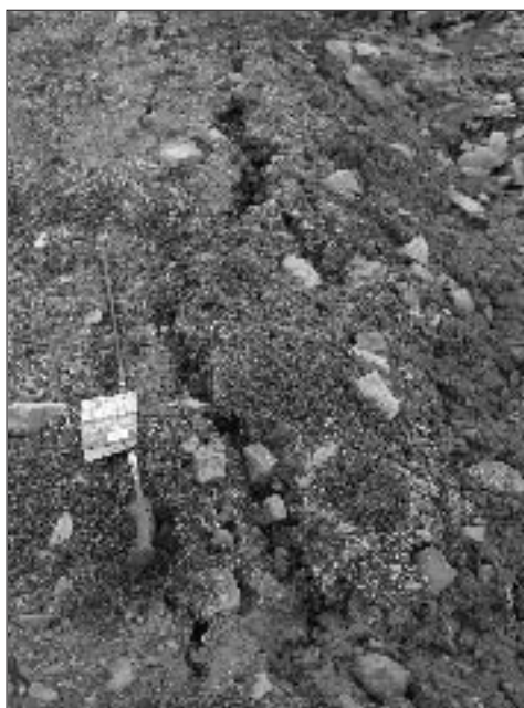
Fot. 3. Zniszczona droga na powierzchni stożka napływowego
